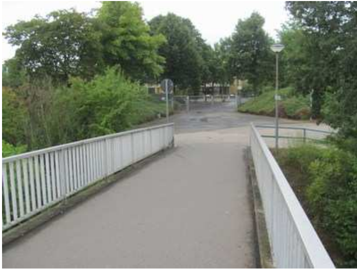
Nordausgang Schule. Links den Fußweg bis zur Brücke.
